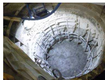
図-6 杭頭部撤去時の健全性確認
