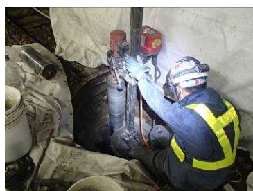
図-4 コアドリル削孔
