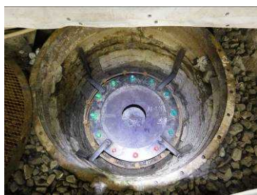
図-5 アンカーフレーム設置
