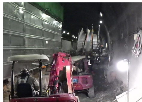
写真-1 掘削状況
