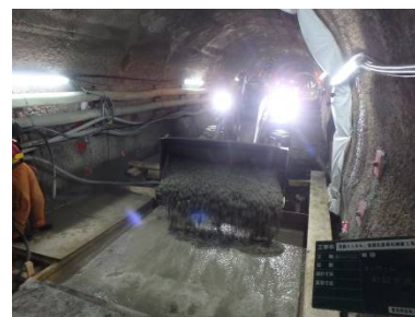
写真-4 インバート打設
