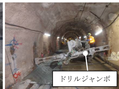
写真-3 ロックボルト工
