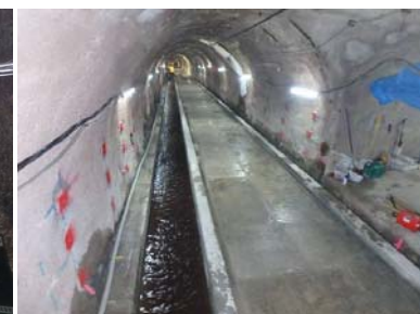
写真-5 補修完了全景
