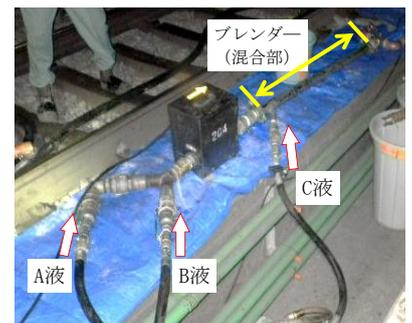
写真-3 材料混合状況
