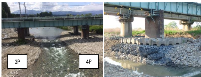
図-8 応急対策施工後
