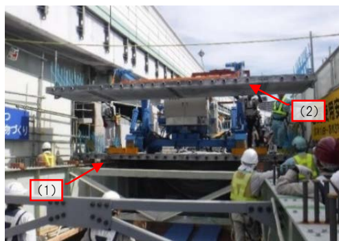
写真-1 床版架設状況
