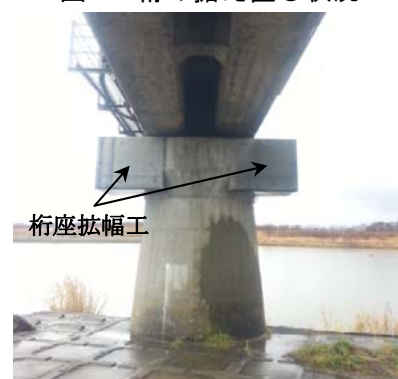
図5 復旧工事の完了状況
