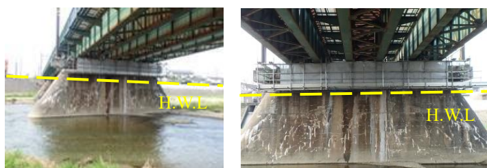
写真7 吊り足場の設置状況
