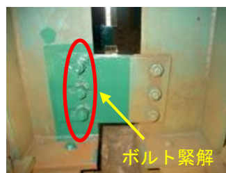
写真5 連結工緊解
