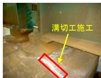
写真6 化粧モルタル撤去 および溝切工
