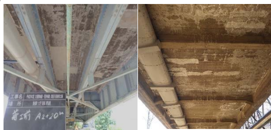
写真-3 床版状況（施工前）
