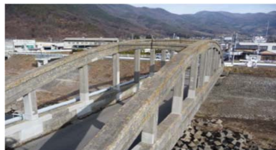
写真-2 アーチ部状況
