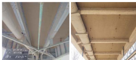
写真-4 床版状況（施工後）
