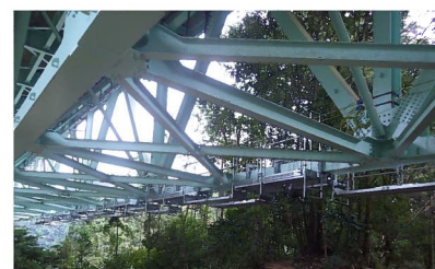
図-7 仮設検査路足場の設置状況（左：試験施工時 右：補修施工）
