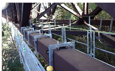
図-7 仮設検査路足場の設置状況（左：試験施工時 右：補修施工）
