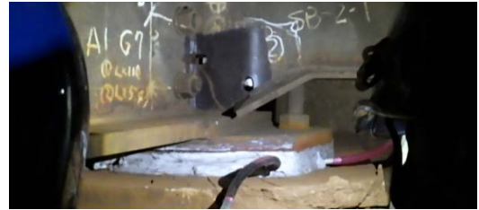
図-1 樹脂注入の施工状況
