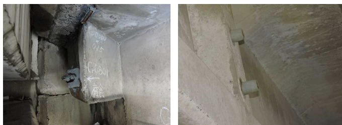
写真-2.1 露出した定着部（鋼棒及び定着板、カプラー）
