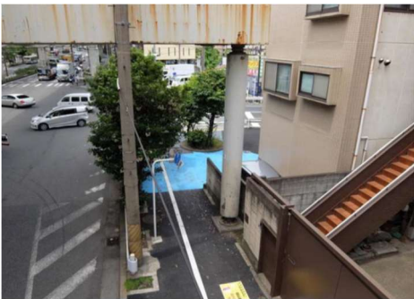
写真-1 横-148ロッキング橋脚
