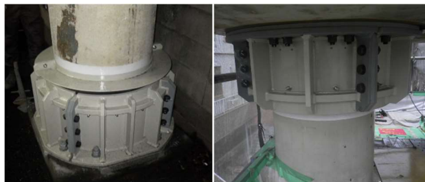
写真-2 横-148 転倒防止装置
