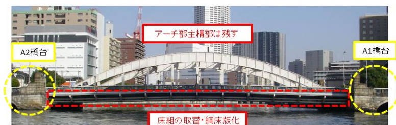
図-1 堂島大橋の長寿命化対策
