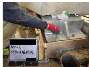
(b) アンカーボルト設置
