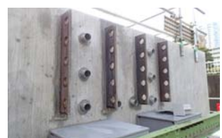
図-2 高耐震性パイルベント橋脚施工手順
