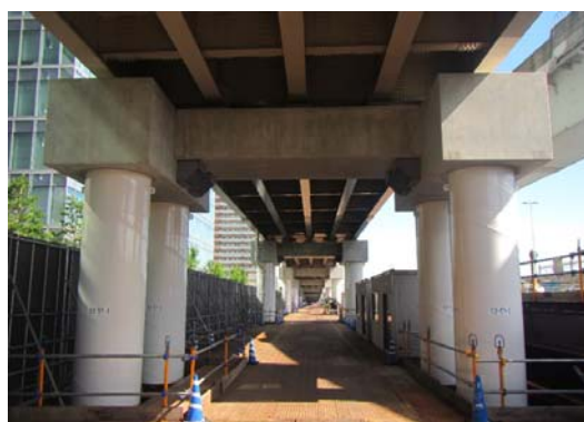
写真-1 高耐震性パイルベント橋脚
