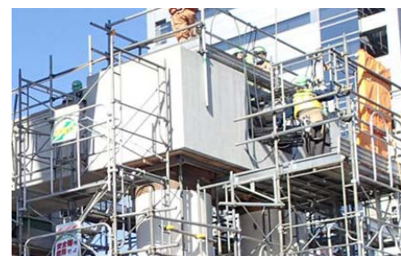
図-2 高耐震性パイルベント橋脚施工手順
