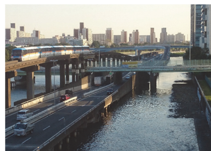
写真-1 着工前の東品川栈橋部
