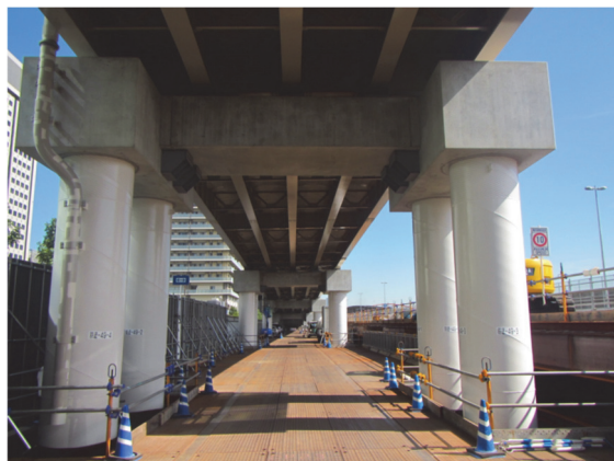
写真-2 高耐震性パイルベント橋脚全景
