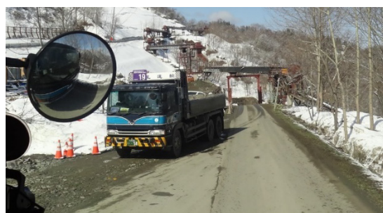
図－1 新桂沢ダムの原石運搬道路
