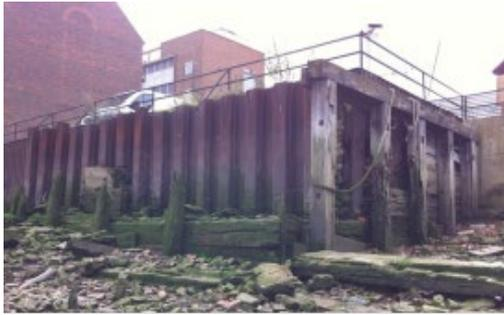
写真-1. 老朽化した鋼矢板擁壁
