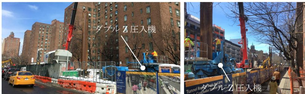
図-2. ダブルZ圧入機による杭施工状況
