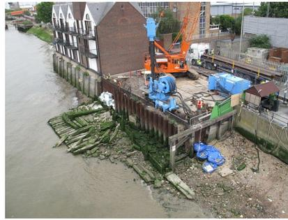
写真-2. シングルZ圧入機による杭施工状況
