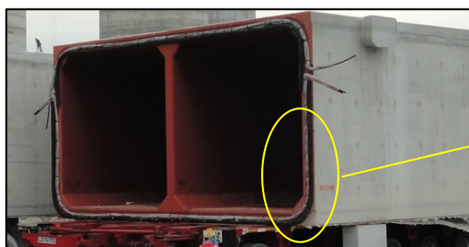
図-6 グラウトソック取付状況
