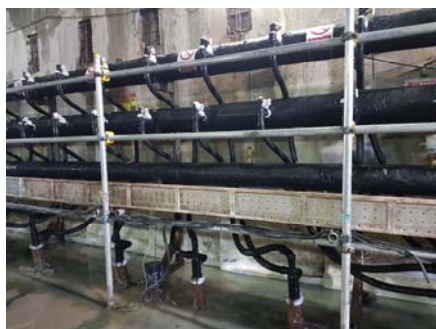
図3 ブライン配管と凍結管の接続
