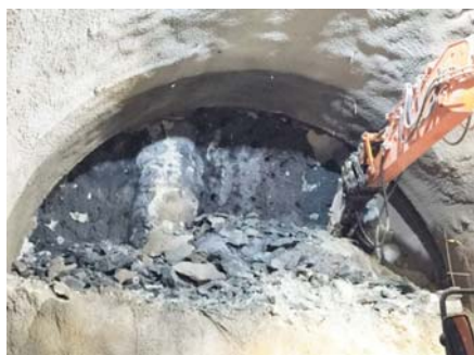
図 7 既設杭撤去状況
