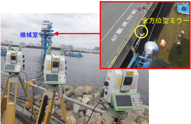
写真-3 沈埋函誘導状況
