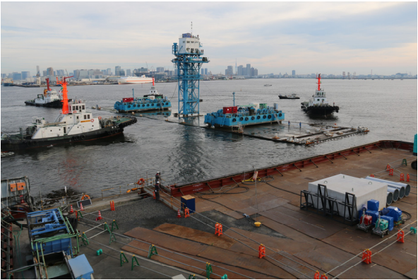
写真－1 沈埋函係留作業
