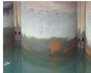
写真-5 継手管内洗浄時の排出状況
