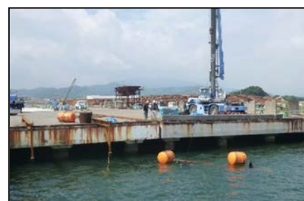
写真-3 岸壁側面からの搬出
