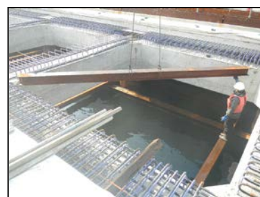
写真-4 支保の撤去状況
