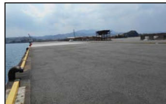
写真-1 岸壁(-11m)全景
