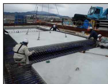
写真-6 据付時（過密な鉄筋）
