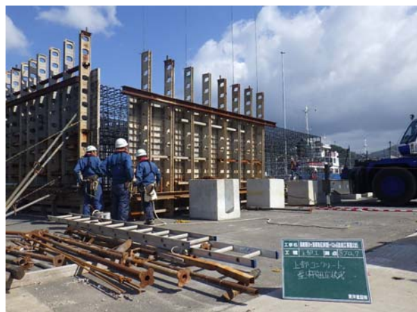
図-4 別ヤードでの型枠組立状況
