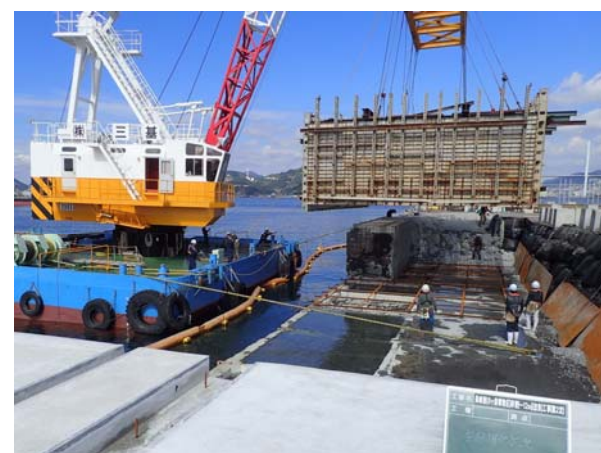
図-5 鉄筋型枠一括据付状況
