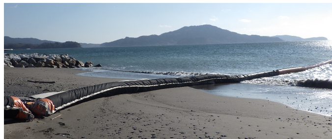
写真-2 補強型汚濁防止フェンス設置状況
