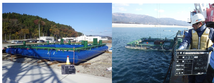
写真-3 汚濁防止フェンス枠の使用状況
