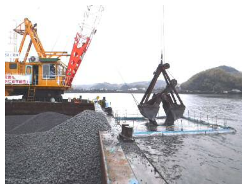
図-10 施工状況写真
