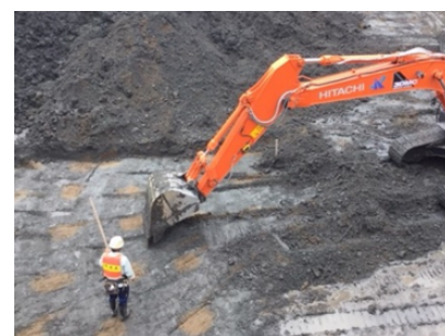
写真-1 掘削深さ管理イメージ
