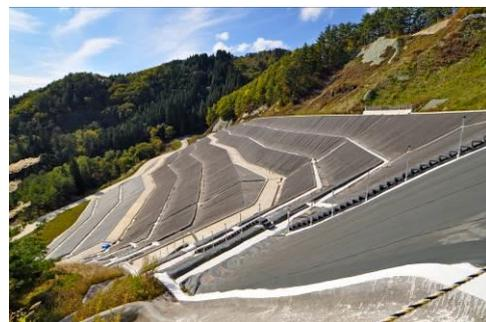
写真-1 現場の遮水シート工
