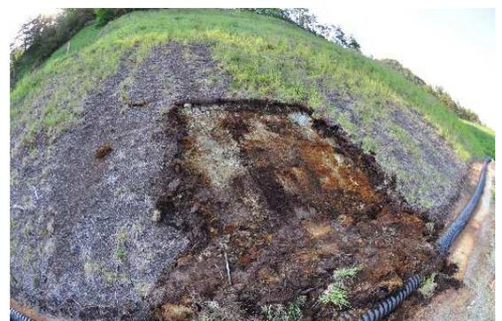
写真-1 既存モルタル吹付部の劣化状況
