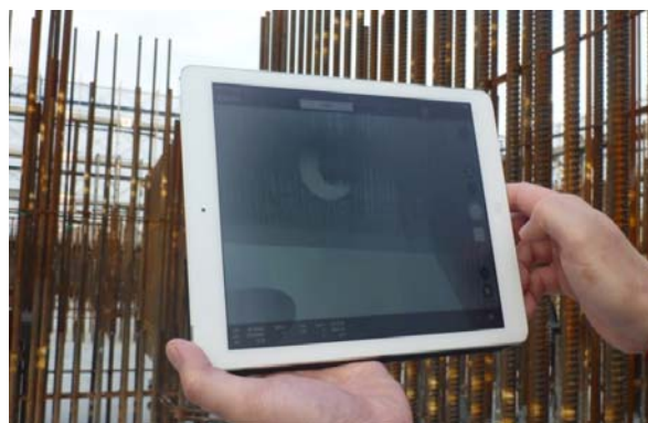
図-2a AR システムによる 施工イメージの可視化 (開口部)
