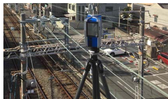
写真-3 3D スキャナによる現況計測状況
