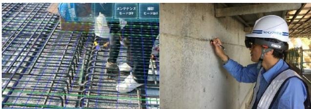
写真-1 MRデバイス装着による作業のサポート
