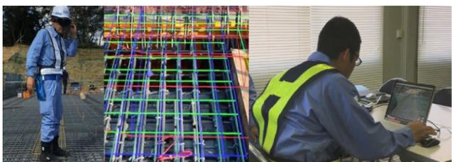
写真-2 現地と工事事務所の遠隔管理
