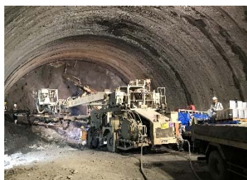
写真-1 施工状況全景
