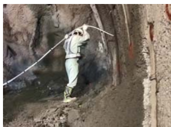
写真-3 インナーチップ 建込状況
