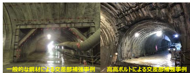
写真-6 交差部補強事例
