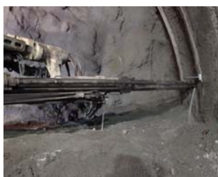
写真-2 打設状況
