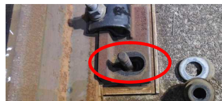
写真4 Tボルト穴位置（移動後）
