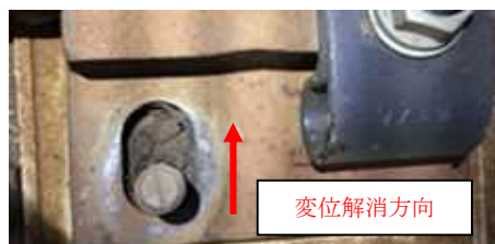
写真 2 T ボルト穴位置（右レール FC 側）
