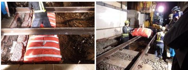
写真1 D・BOX敷設時施工写真
