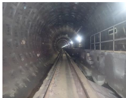
写真－1 羽田トンネル
