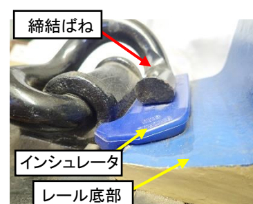
図 4 締結ばねの押さえ部分近傍
