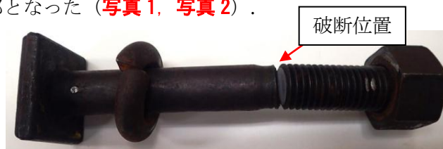
写真 1 ボルト折損状況
