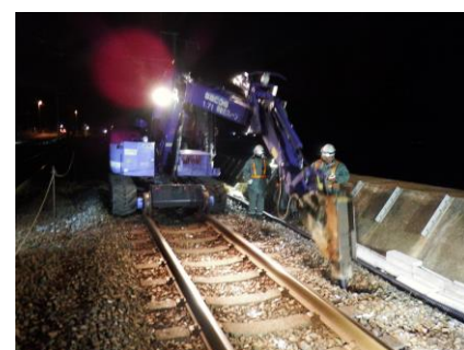
図 7 強制振動締固め施工状況
