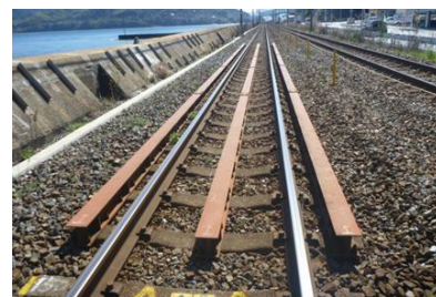
図2 簡易工事桁の設置状況
