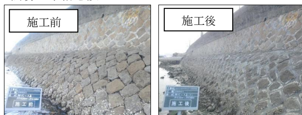
図3 目地詰め施工状況
