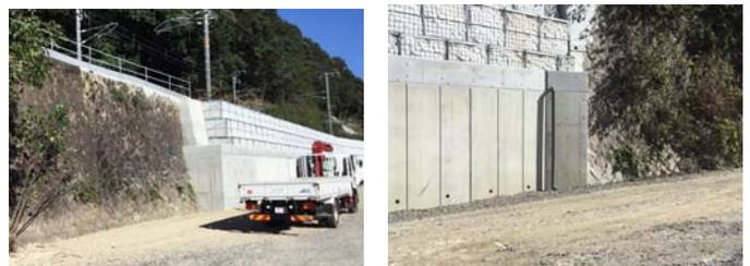
図-4 既設石積み擁壁端部処理
