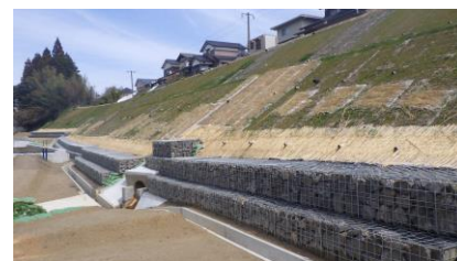
図 9 復旧対策完了後の状況
