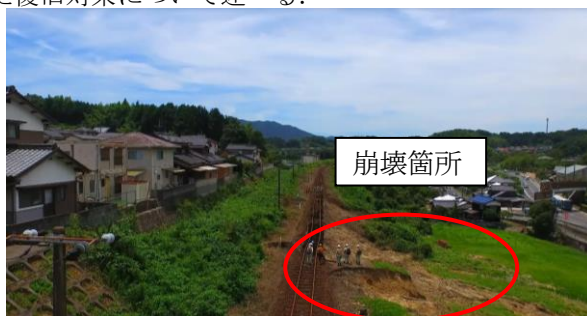
図 1 被災状況写真(起点方から終点方を望む)
