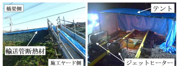
写真1 寒中コンクリート対策実施状況
