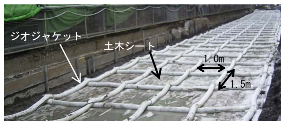
写真-1 格子状補強シート(仮下り線)
