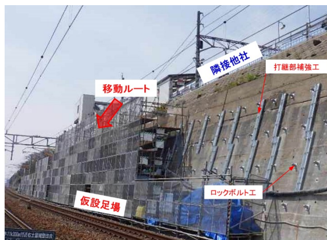
写真-3 施工計画・施工概況
