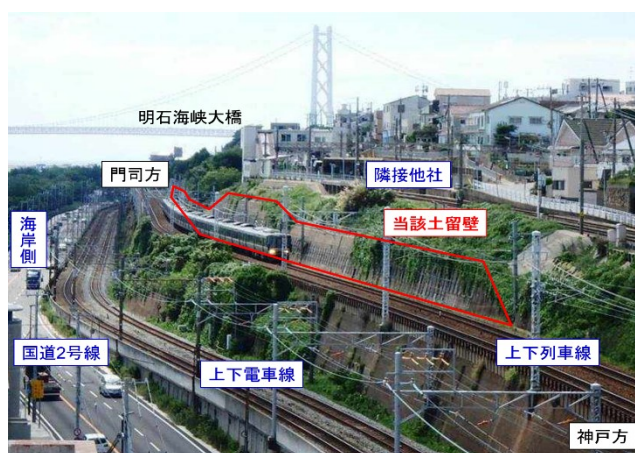
写真-2 現場概況
