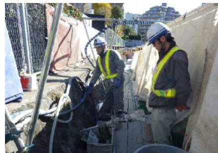
写真1 石積み擁壁天端での施工状況
