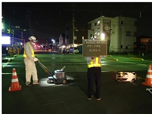
写真-1 地中レーダ探査
