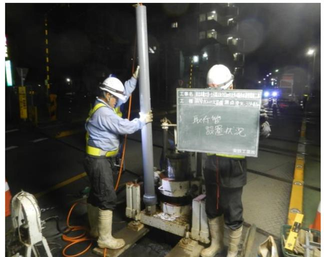
写真-2 取付管挿入
