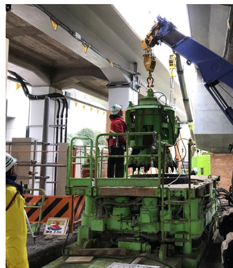
写真-3 掘削状況
