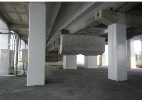
写真-2 高架下状況
