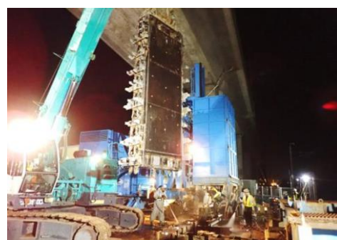
写真1 TRD 工法施工状況
