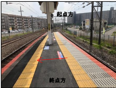
写真 4 施工後（ホーム盤下げ後）
