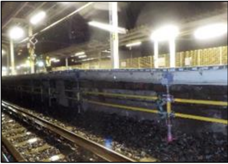
写真 2 下本線の仮設ホーム状況
