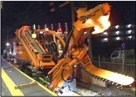
写真 1 道床掘削作業機
